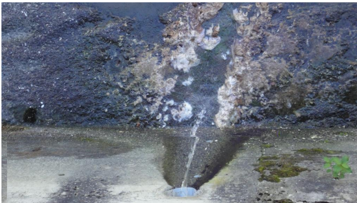
Figure 3 : vue zénithale des rejets
